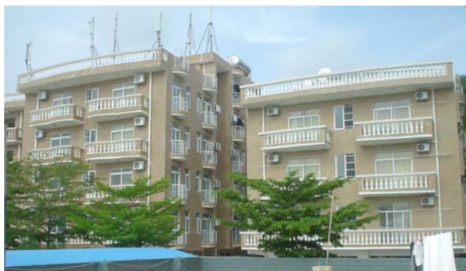
右为 A 栋，左为 B 栋，A 栋一层为游泳池，顶层为舞池和露天影院。B 栋屋顶有电讯的天线。
